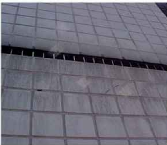
FIGURA 6.4 Manchamento do selante e do revestimento.
