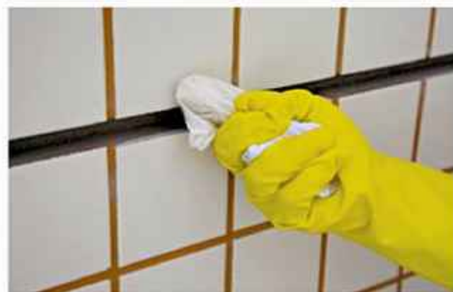
FIGURA 8.11 Procedimento para limpeza da cavidade da junta (substrato).
