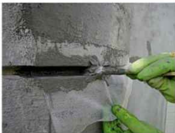
FIGURA 5.3 Membrana impermeabilizante aplicada na cavidade da junta.
