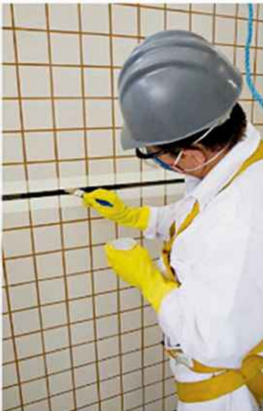
FIGURA 8.14 Aplicação do primer no interior da abertura da junta.
