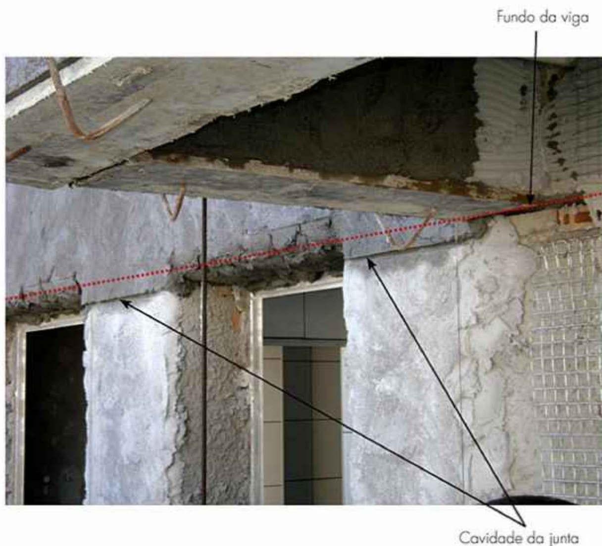
FIGURA 7.3 Junta horizontal: posicionamento não coincide com o fundo da viga.
