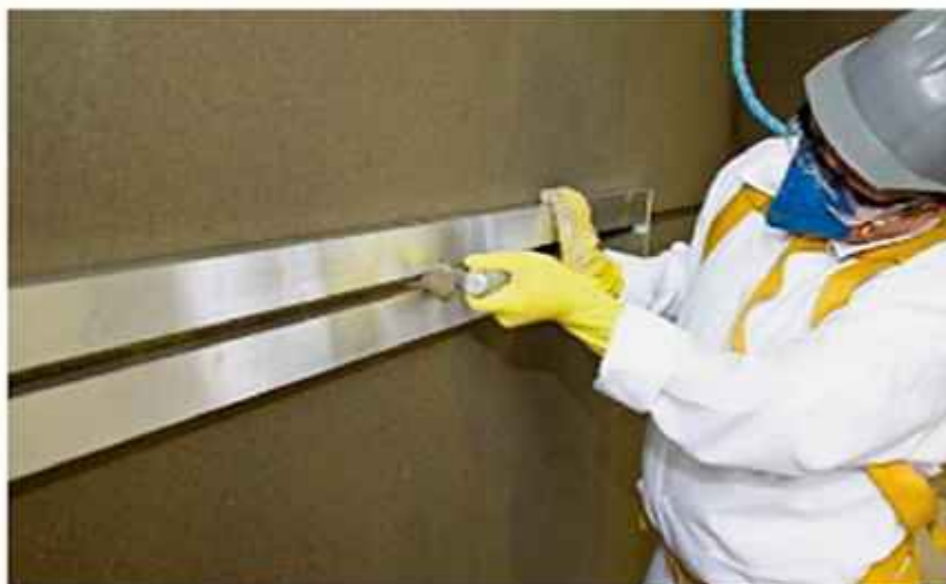
FIGURA 8.7 Execução do corte da junta com auxílio de régua e frisador.
