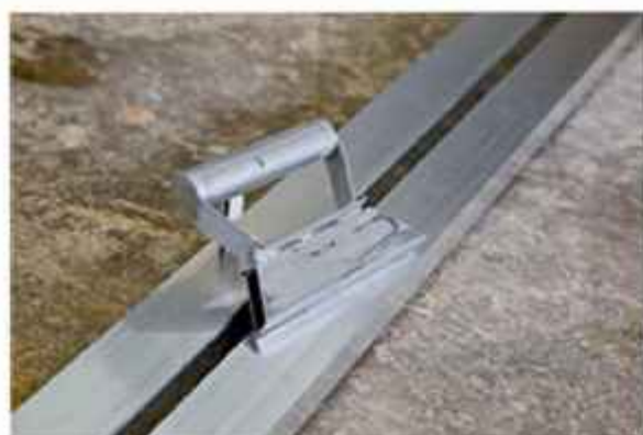
FIGURA 8.3 Detalhe da régua-guia e cortador do revestimento.
