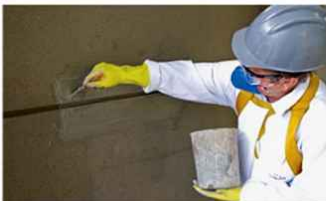
FIGURA 8.10 Procedimento para execução de membrana impermeabilizante e estrutura com véu de poliéster.
