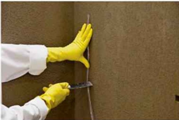
FIGURA 8.5 Demarcação da posição da junta horizontal na fachada, com auxílio do nível de mangueira.
