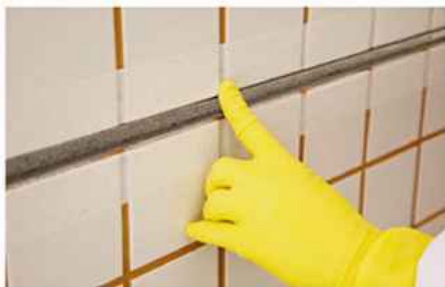
FIGURA 8.13 Proteção das bordas das placas cerâmicas na abertura da junta.
